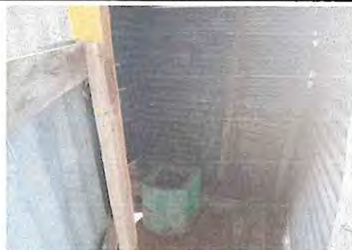
Foto 4: Mejoramiento de baños, sustitución de inodoro por letrina y sustitución de paredes, lámina por block
