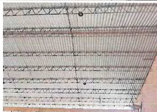
Foto 2: Sustitución de estructura metálica con oxidación, por estructura metálica galvanizada, aulas corredor y cocina
