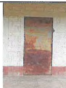
Foto 6: Sustitución de puertas en las aulas
