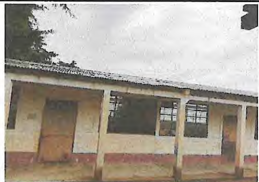
Foto 2: Sustitución de pintura por dentro y por fuera
