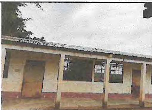
Foto 1: Sustitución de lámina acanalada por lámina troquelada calibre 26, en una aula y la mitad del corredor
