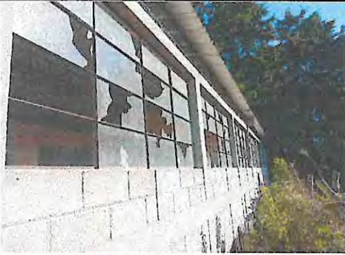
Foto1 Sustitución de vidrios
