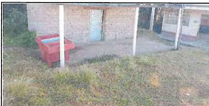
Foto 5: Sustitución de puerta de la cocina
