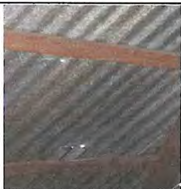
Foto 3: Sustitución de lámina acanalada por lámina troquelada calibre 26, en la cocina de la escuela y estructura de madera por estructura de metal galvanizado
